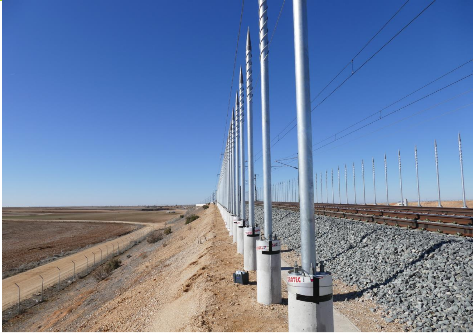
Foto 5. Acción C1 Instalación de prototipo de pantalla. (Obra)
