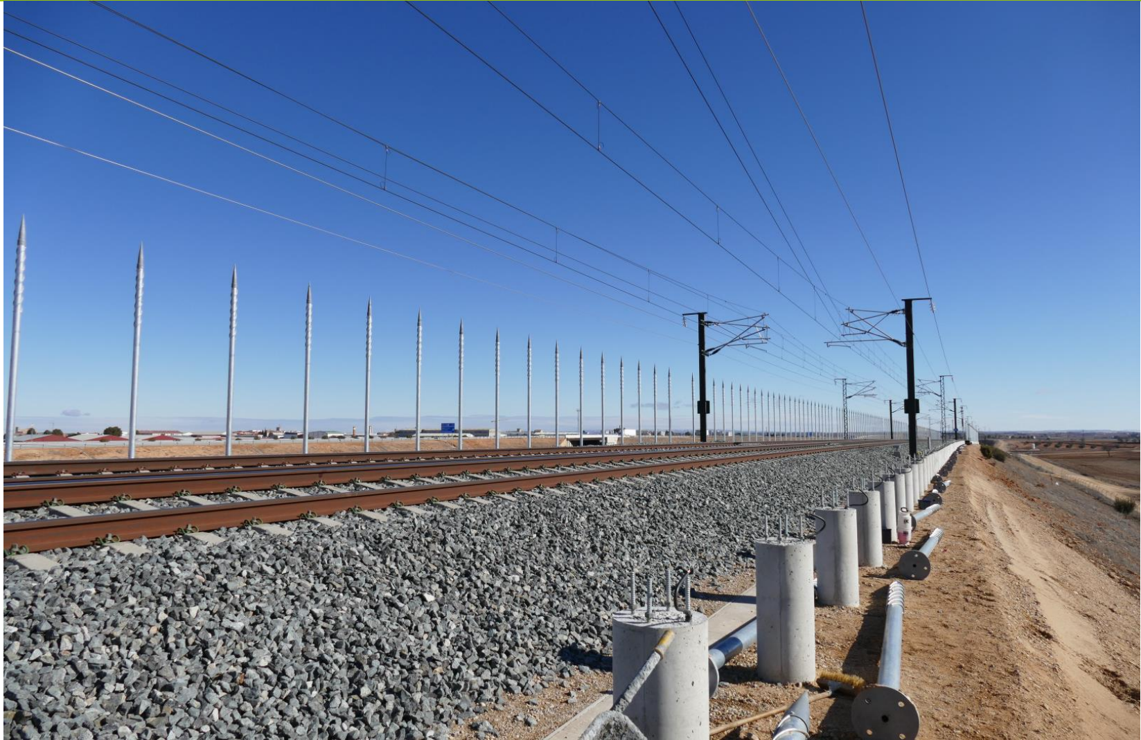
Foto 4. Acción C1 Instalación de prototipo de pantalla. (Obra)
