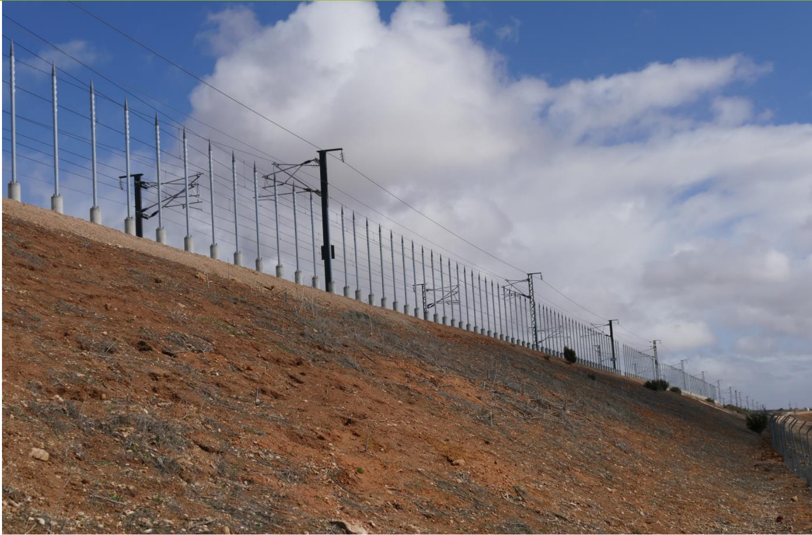
Foto 6. Acción C1 Instalación de prototipo de pantalla. (Obra)
